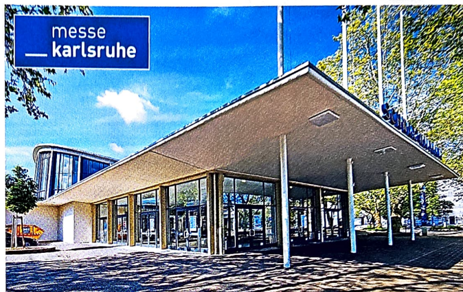
Außenansicht Schwarzwaldhalle, Kongresszentrum Karlsruhe Foto: Messe Karlsruhe onuk
